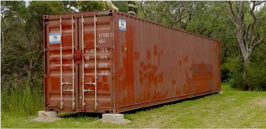
Un conteneur surélevé à l'aide de blocs.
